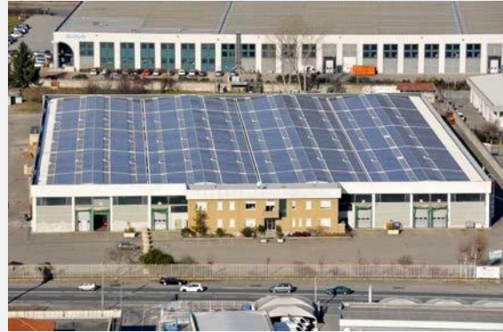
L'impianto di Burolo (To)
